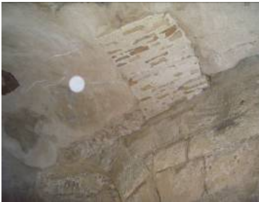
Brocal tapado con cal y ladrillo
