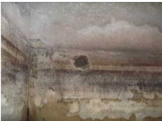
Boca de decantación de aguas
