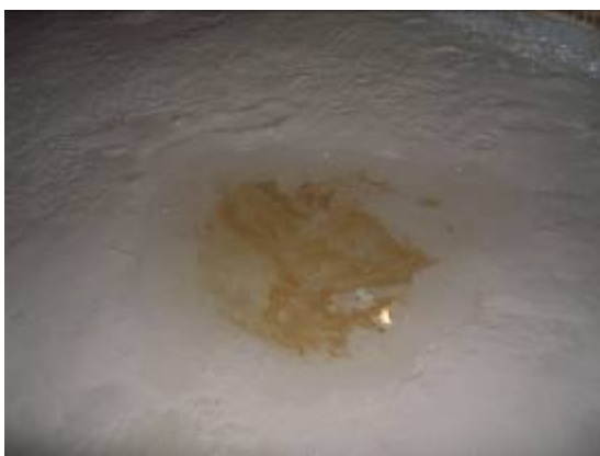
Pozo para toma de agua
