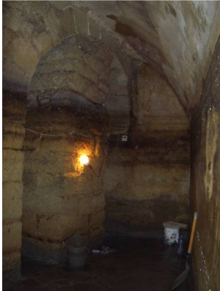
Empotrado en el aljibe se encuentra un pilar central de sillería del que parten dos arcos
