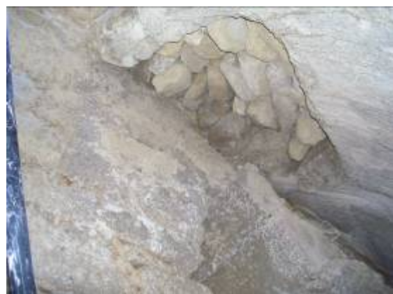
Mampostería de la bóveda
