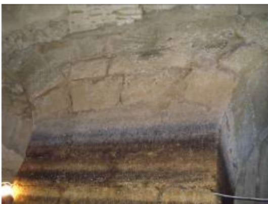
Detalle del arranque de los arcos
